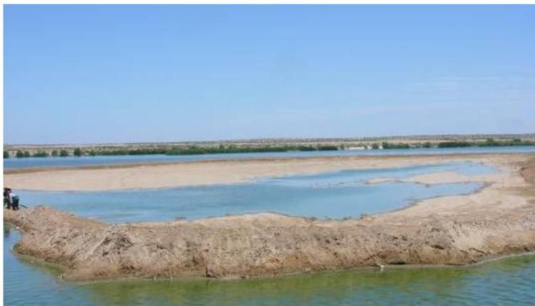
Figura 6. Cama E mostrando la ataguía que delimita la cama. El agua que se ve adentro de la cama fue introducida con una manguera por diferencia de presión para preparar el terreno para la plantación de tule.
