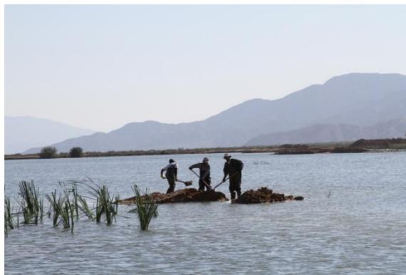
Figura 14. Remoción de ataguía que delimita a las camas de tule. Izquierda a mano y derecha con agua a presión.
