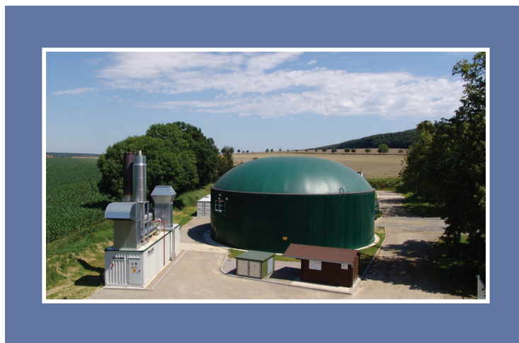
Figura 4.2. Planta de biogás con tecnología de punta. (Foto: Haase Energietechnik Neumünster)
