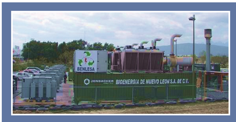
Figura 8.1. Relleno Sanitario, SIMEPRODE-Bioenergía en Nuevo León.
