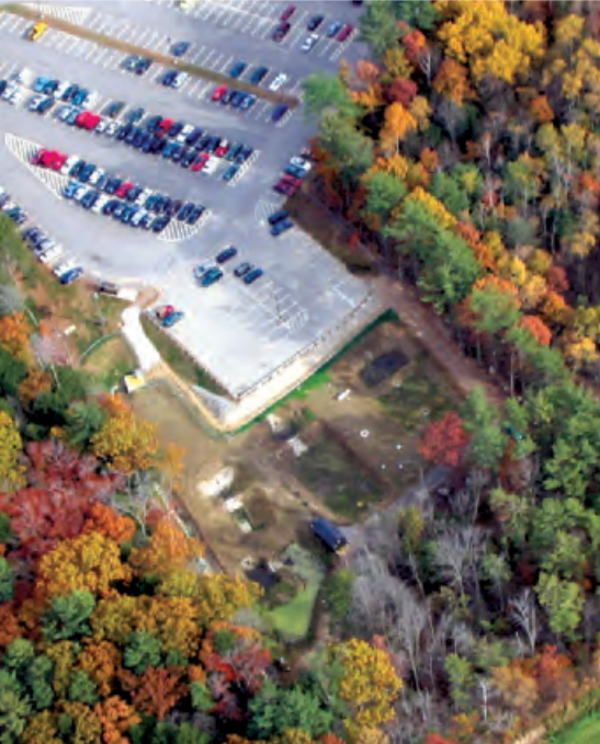
UNH Stormwater Center field site
