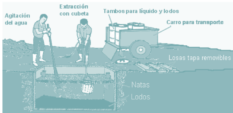
Extracción de lodos del tanque
