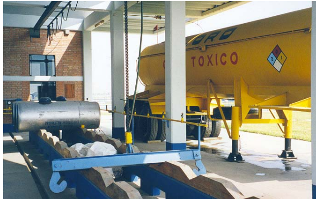
Cilindros de una tonelada y tanque rodante con cloro
