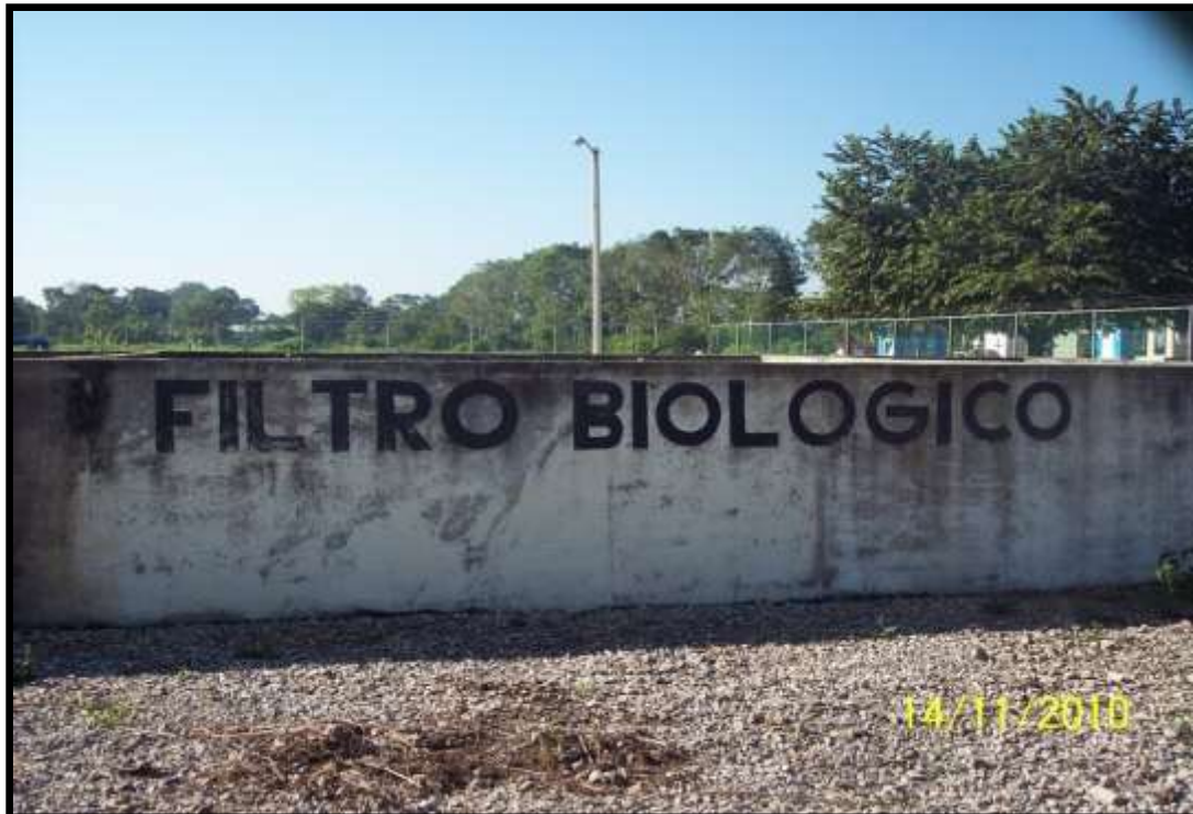
Imagen del filtro biológico de la planta de tratamiento de aguas residuales.
