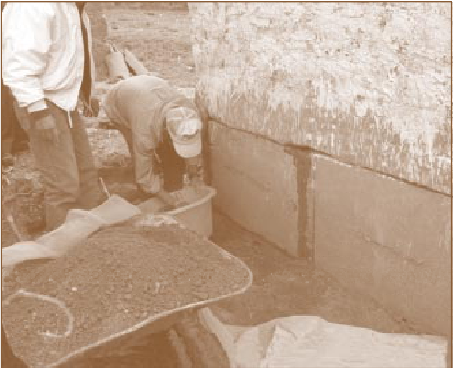
Sellado de la cámara con barro o arcilla
