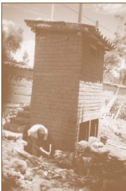
Construcción de una letrina.
