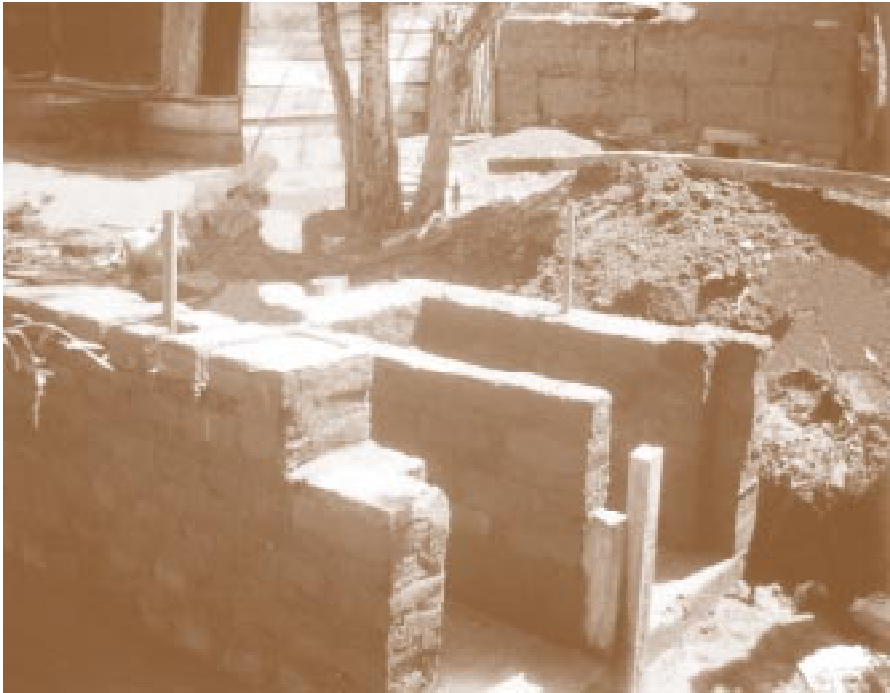
Construcción de letrinas
