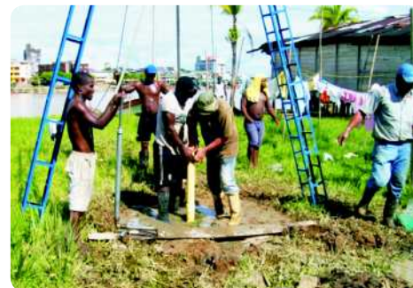
Perforación manual de pozos profundos de pequeño diámetro, municipio de Quibdó, Chocó.
