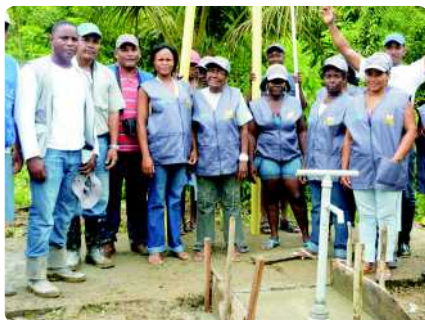
Pozo terminado, comunidad El Trapiche, municipio de López de Micay, Cauca.
