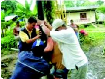
Foto 1, 2 y 3: Procedimiento de fabricación del filtro, encamisado e introducción en el pozo, Tumaco, Nariño.
