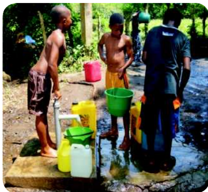
Pozo construido en el barrio Puerta del Sol, municipio de Tumaco, Nariño.
