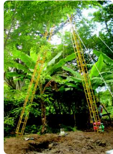
Esquema de la torre de perforación: polea, acople, columnas, ángulos. Tumaco, Nariño.
