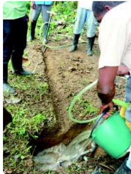
Fotos 3 y 4: llenado de la fosa y drenaje de los fluidos de la perforación. El Charco, Nariño.
