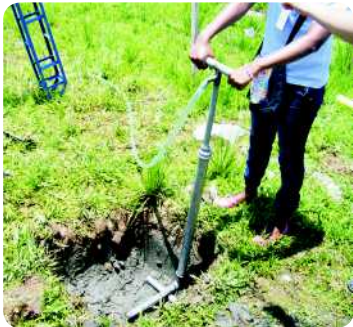
Fotos 1 y 2: construcción de la fosa de lodos a máximo 2 m de distancia de la perforación del pozo, y ubicación de la bomba de lodos en el fondo de la fosa. Quibdó, Chocó.
