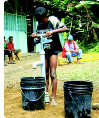
Aspectos de la bomba manual funcionando. Municipio de Tumaco, Nariño.
