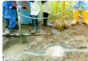
Fotos 3 y 4: llenado de la fosa y drenaje de los fluidos de la perforación. El Charco, Nariño.
