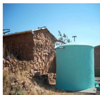
Tanques de cosecha de agua de lluvia
