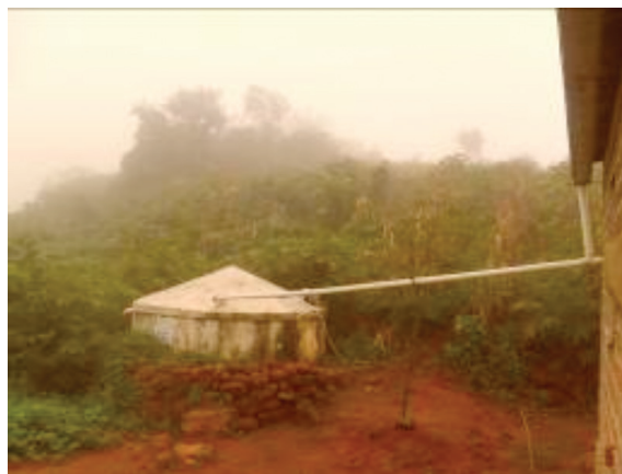
Figura 3. Cisterna del P1MC en el municipio de Santa Cruz da Baixa Verde, PE. Out. 2013
