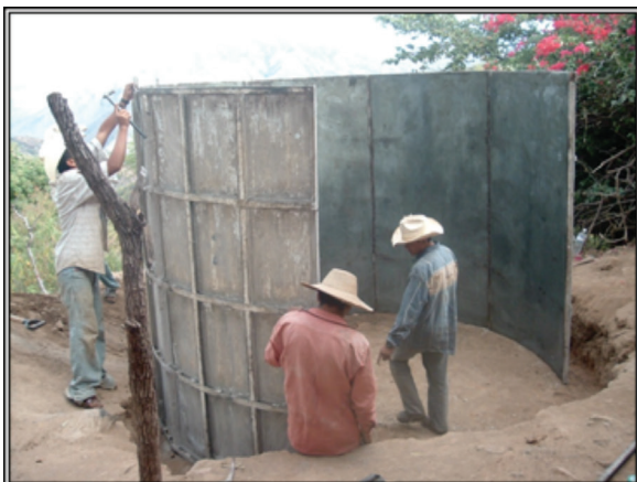
Foto 7. Armado de molde exterior
