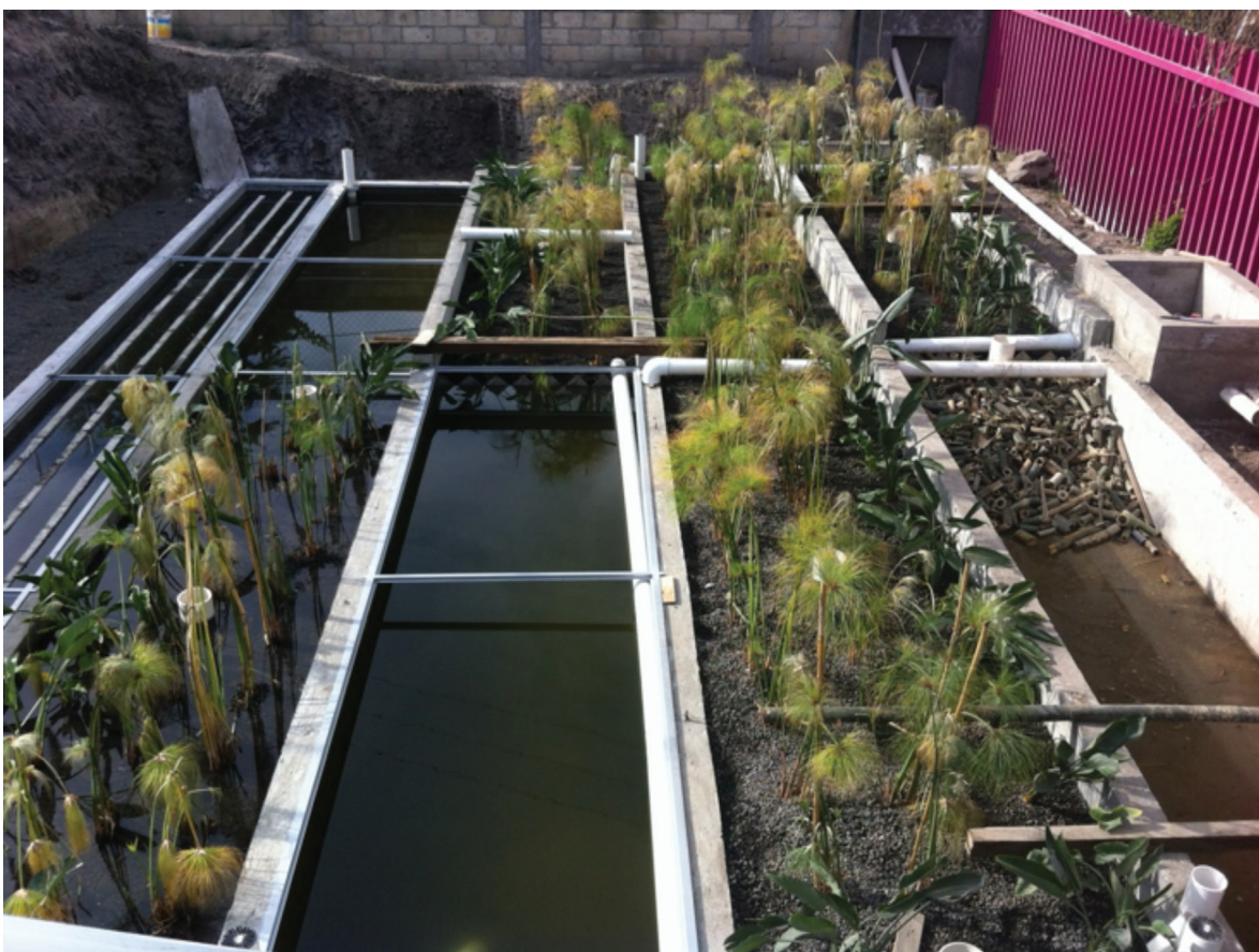
Foto 1. Sistema de tratamiento con humedal, instalado en el Centro de Desarrollo Comunitario de Alpuyecá, Morelos
