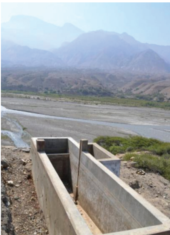
Figura 4-1: Sedimentador directo sencillo (abandonado), Punta Moreno, Cascas, Perú (4 de diciembre de 2012).
