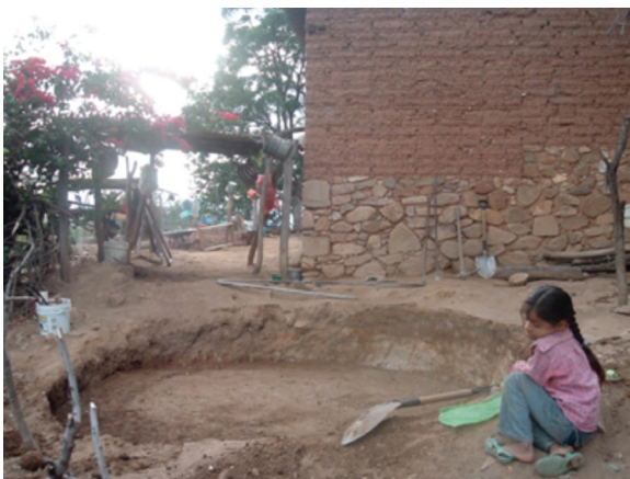
Foto 6. Ubicación del lugar de construcción
