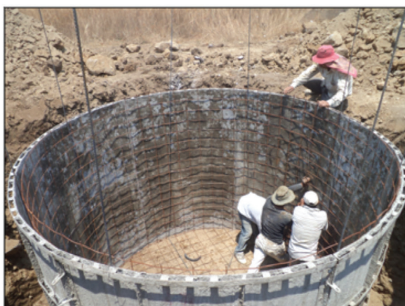
Foto 8. Colocación y amarre de malla de piso y muro
