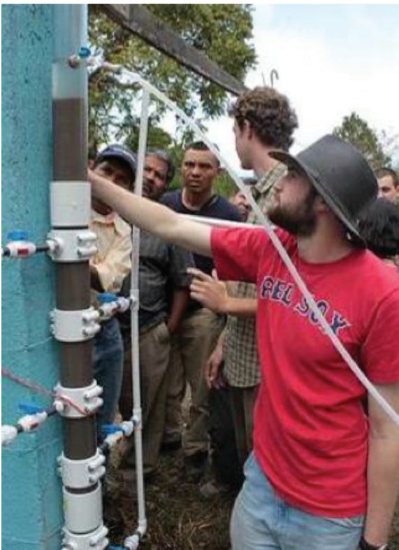
Figura 4-14: Filtro rápido en múltiples capas (FRAMCa) tamaño piloto de 3 litros por minuto de capacidad, hecho de tubería plástica, mangueras, y accesorios. No utiliza bombas y se efectúa el retrolavado con agua bruta.
