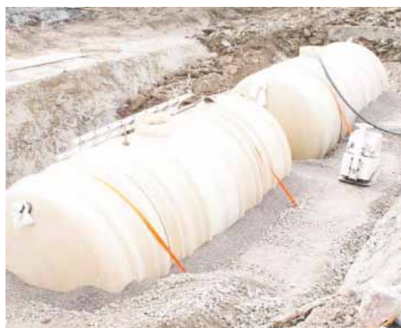
Gráfico 17: Tanques de almacenamiento durante la construcción del área de viviendas en Kullön, Suecia. Cada tanque tiene 12 m 3 Foto: Mats Johansson, VERNA
