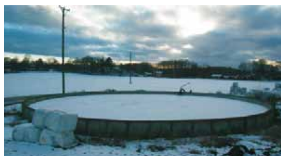
Gráfico 16: Tanques de mezcla en temporada de invierno, Suecia. Estos tanques de mezcla serán usados para orina humana, y serán equipados con una cubierta para minimizar las pérdidas de amoníaco. Foto: Lennart Qvarnström
