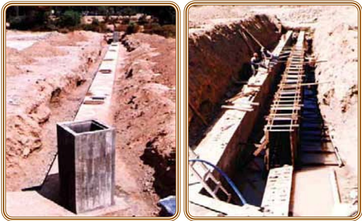
Figura 2.2.2 Galería Río Seco (Tarata); Etapas de la construcción
