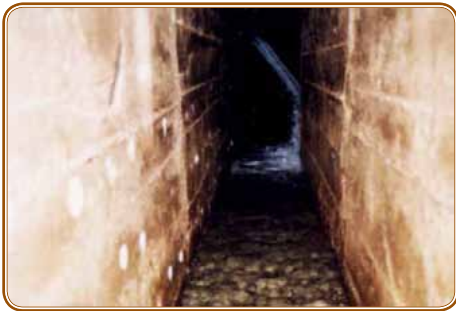
Figura 6.32 Galería construida con hormigón ciclópeo. Se observa las barbacanas practicadas
