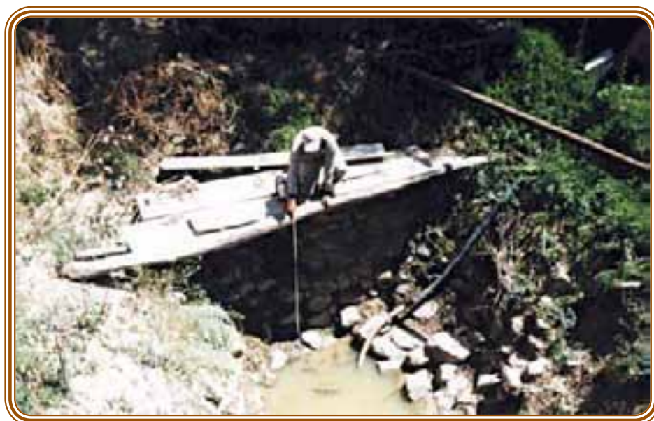
Figura 15 Pozo Excavado 2, "PE-2"
