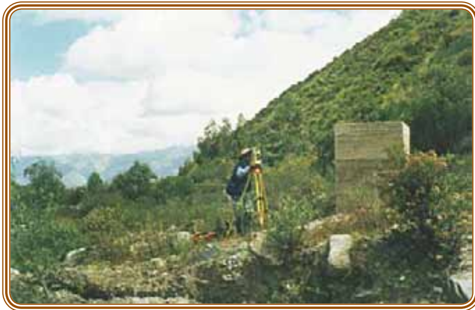
Figura 5 Levantamiento topográfico con ayuda de una Estación Total
