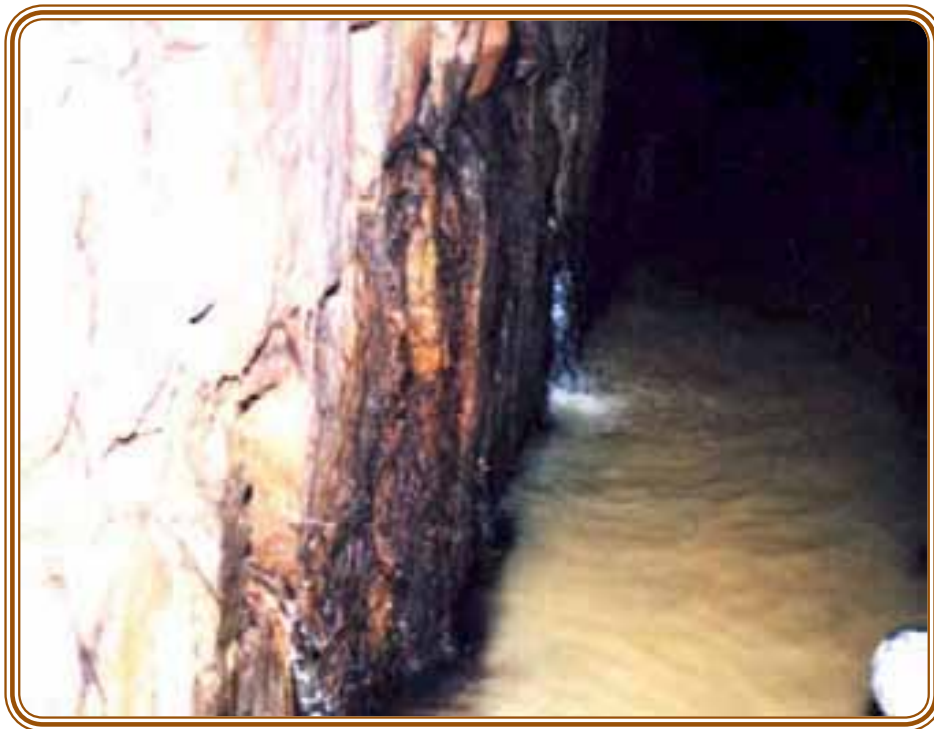
Figura 2.2.7 Galería Kuru Mayu; raíces dentro la galería
