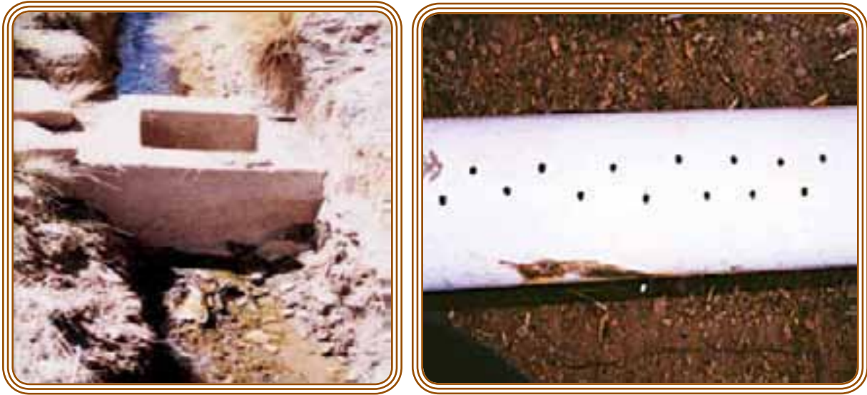
Figura 2.3.1 Galería Realenga; cámara de inspección y tubería de ampliación de la galería
