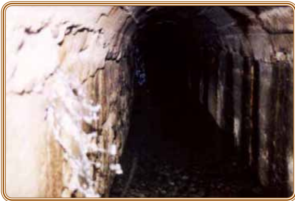
Figura 2.2.6 Galería Thako Thako; interior de la galería, vista puntual de ingreso del agua, el muro aguas arriba es de mampostería de piedra y aguas debajo de H° C°
