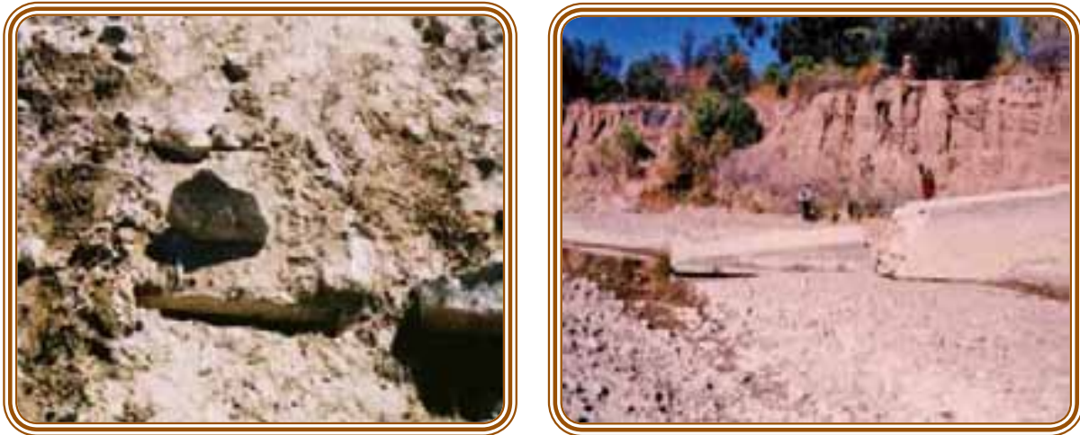
Figura 2.4.1 Galería Maldonado; muro de protección
