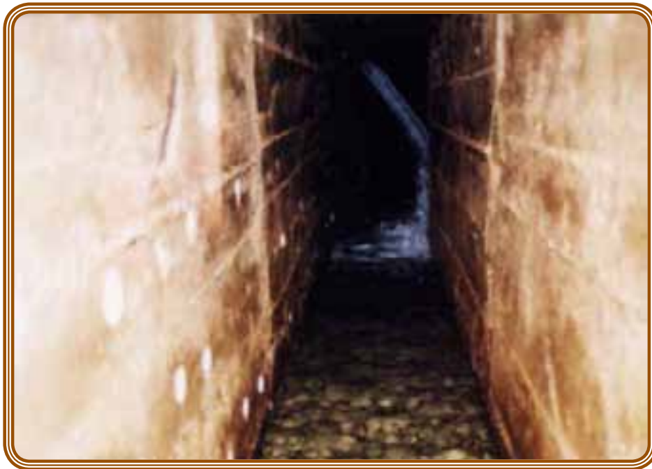
Figura 2.2.4 Galería Tajras; interior de la galería (muros de H°C°, barbacanas 2" PVC)
