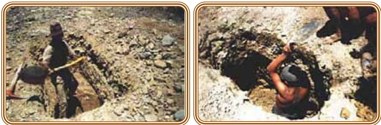
Figura 10 Excavación de calicatas Río Seco Tarata
