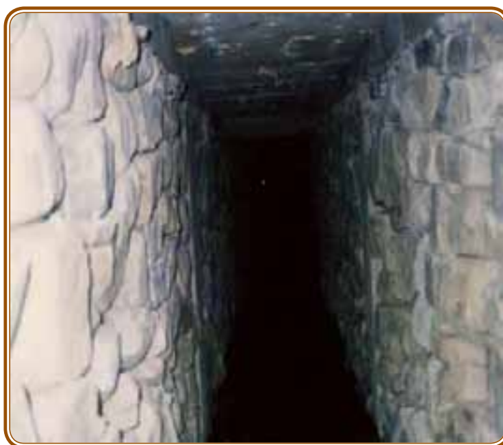
Figura 6.30 Mampostería seca empleada para conformar los muros de una galería
