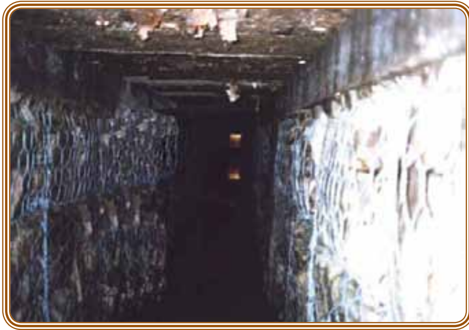
Figura 2.2.3 Galería Montecillos; vista interior (estructura con gaviones) 1
