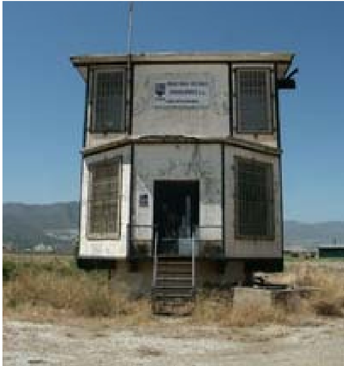
Pozo Ranney en el Bajo Guadalhorce (Málaga)
