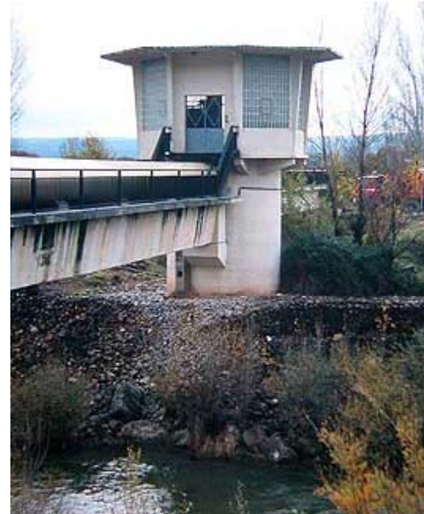
Pozo Ranney en el río Jarama (Madrid)
