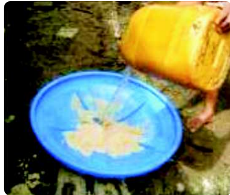
Proceso de lavado de la arena del filtro.
