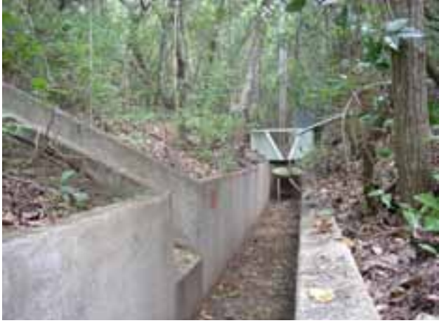
Vertedor de flujo en una cuenca hidrológica experimental.
