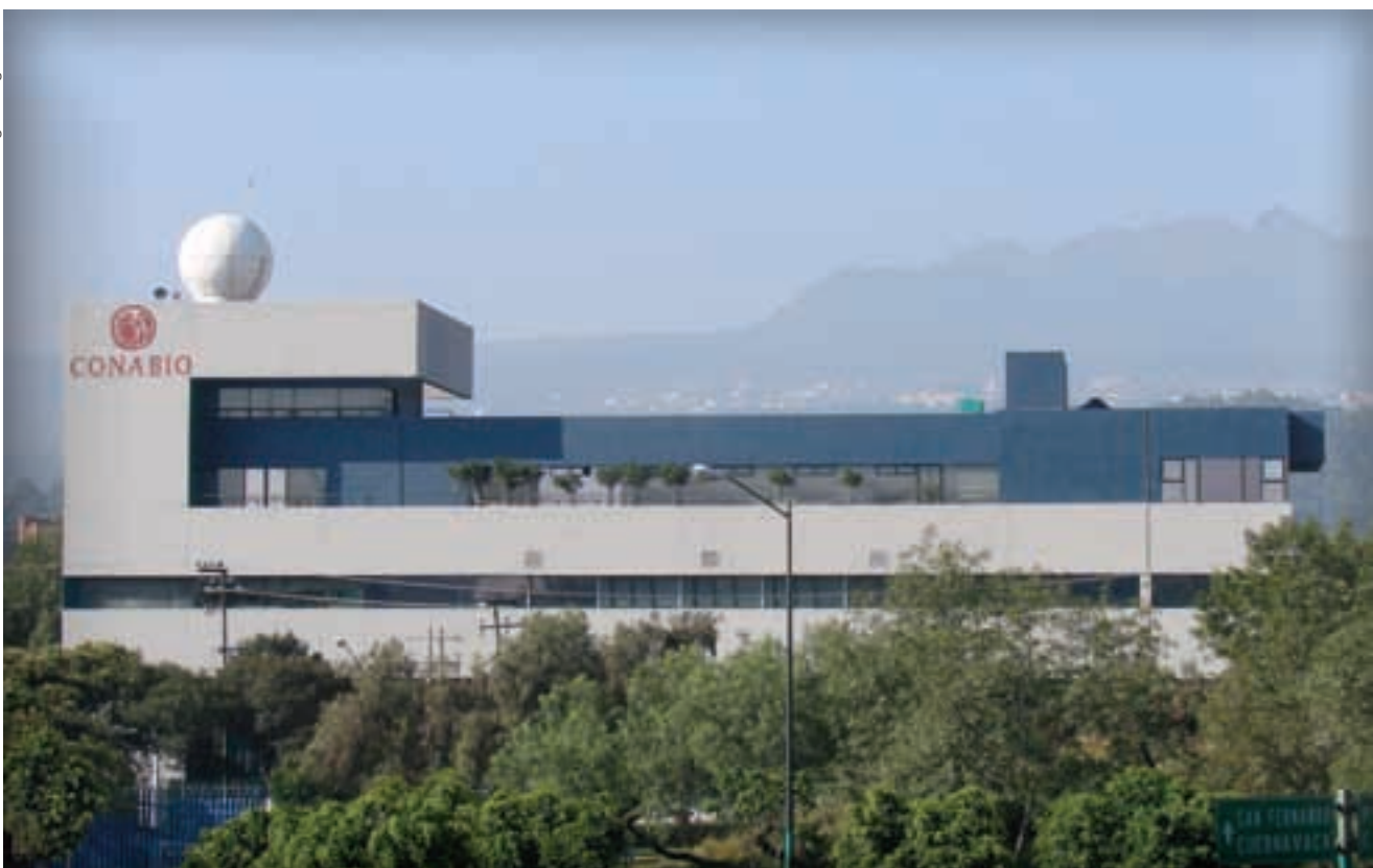
Edificio de la Conabio, ciudad de México.
