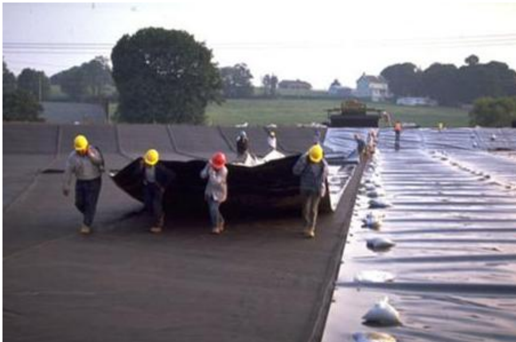
Figura 4 Construcción de sitio de disposición de biosólidos
