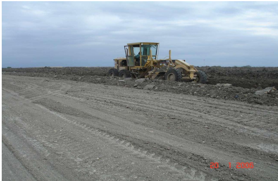
Figura 3 Disposición de lodos en monorrelleno
