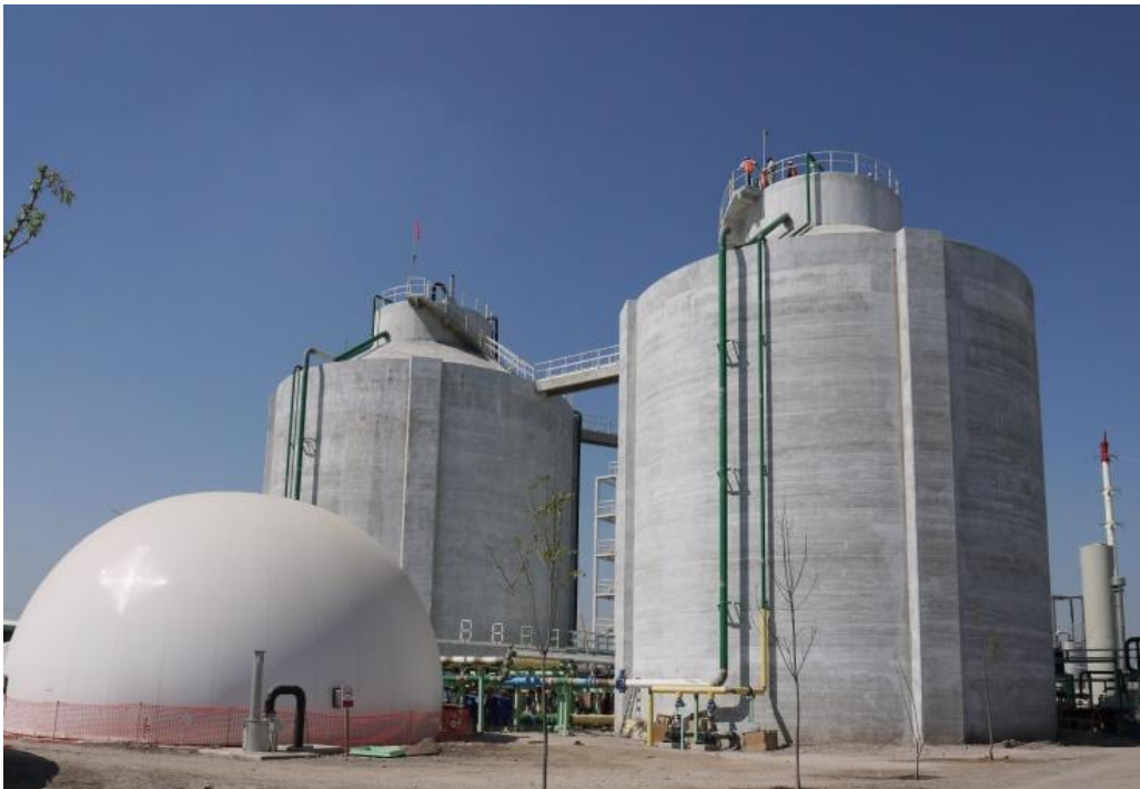
Figura 7 Digestores anaerobios y esfera de almacenamiento de biogás
