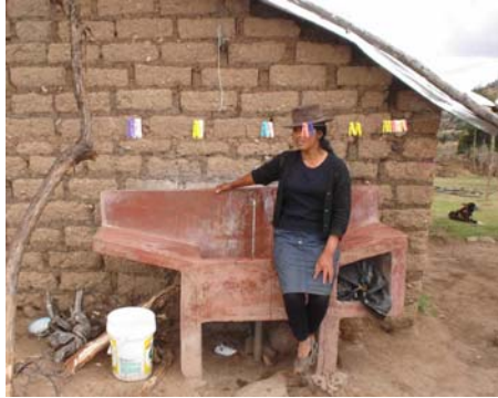
Nivel de servicio con conexión domiciliaria fuera de la vivienda
