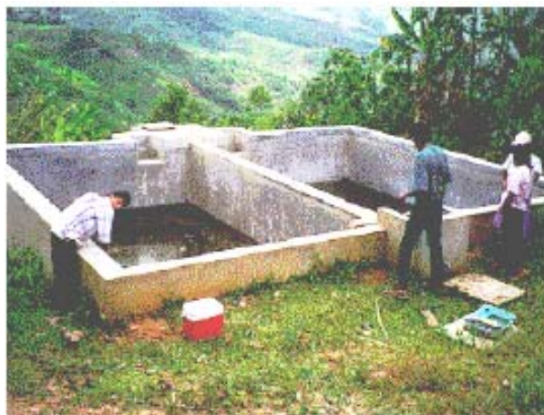
Filtro lento de arena en una zona rural
