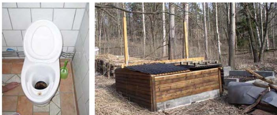
Figura 14. (izquierda) El sistema de saneamiento es único: un sistema de desviación de orina con recolección de las heces secas en un edificio de dos pisos. Foto: Mats Johansson.
