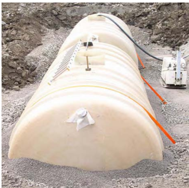
Figura 19. Esta fotografía muestra los tanques de orina de Kullön durante el proceso constructivo. Los tanques estarán cubiertos con suelo. Foto: Mats Johansson.
