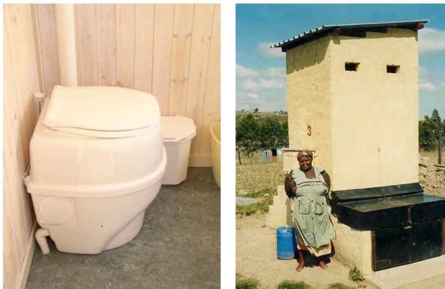
Figura 2. Desviación de orina in-situ en poblaciones de baja densidad a) Suecia, Separett es un inodoro seco de desviación de orina para uso interior. Foto: Mats Johansson. b) Sudáfrica, foto: Aussie Austin.
