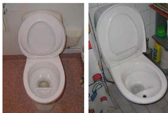
Figura 8. Dos modelos de inodoros desviadores de orina en el mercado sueco. a) Gustavsberg Nordic 393U y b) WM-Ekologen DS.
