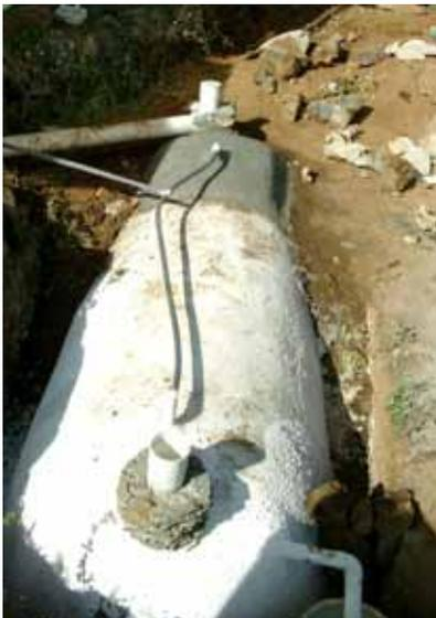
biodigestores de flujo horizontal (para producción de biofertilizante):
