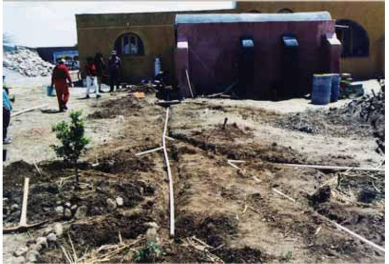
En la gráfica se ve un sistema de «drenaje enramado» realizado en el estado de Guanajuato, antes de ser enterrados los tubos de PVC, que llevan el agua gris a una serie de árboles frutales. Los tubos deben tener una pendiente continua de 2%,
