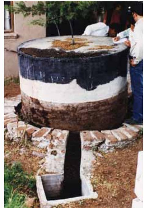
Biodigestor de flujo ascendente tipo campana - este modelo ha sido muy popular para la producción de biogas, aunque no es apto para un aprovechamiento eficiente del biofertilizante
