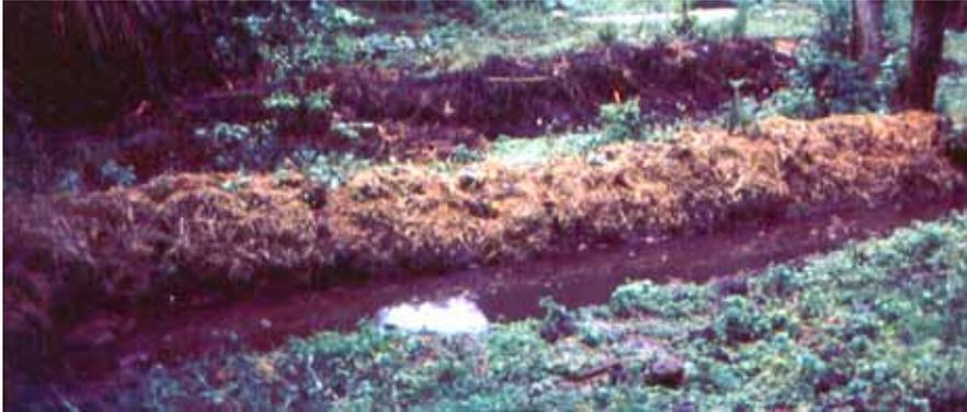
arriba- zanjas de infiltración después de un aguacero fuerte
