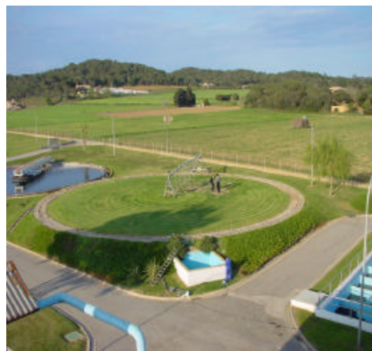
Figura 1. Vista del sistema de IPm
