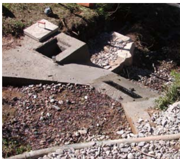
Captaciones mediante toma rejilla. Los Corderos Catamarca y Maimará Jujuy.
