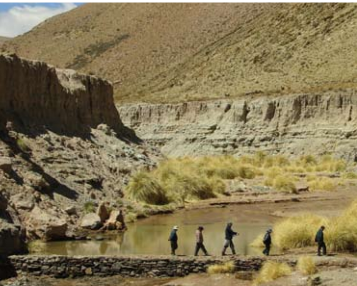
Represamiento realizado con piedra calzada y represamiento con piedra y tierra, se observa la salida lateral de la toma para derivación del agua.
