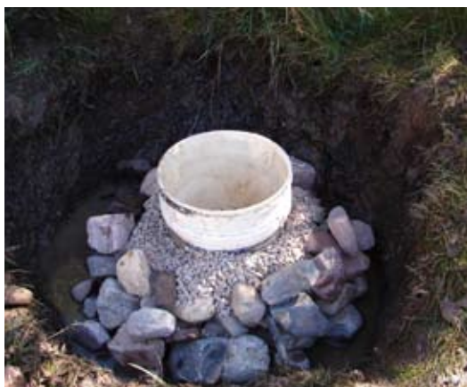
Captación de un manantial realizada con un balde de 20 litros perforado en los laterales, y enterrado. Se observa además la salida a la conducción, también se lo rellena con ripio para mejorar la captación. Maimará.
