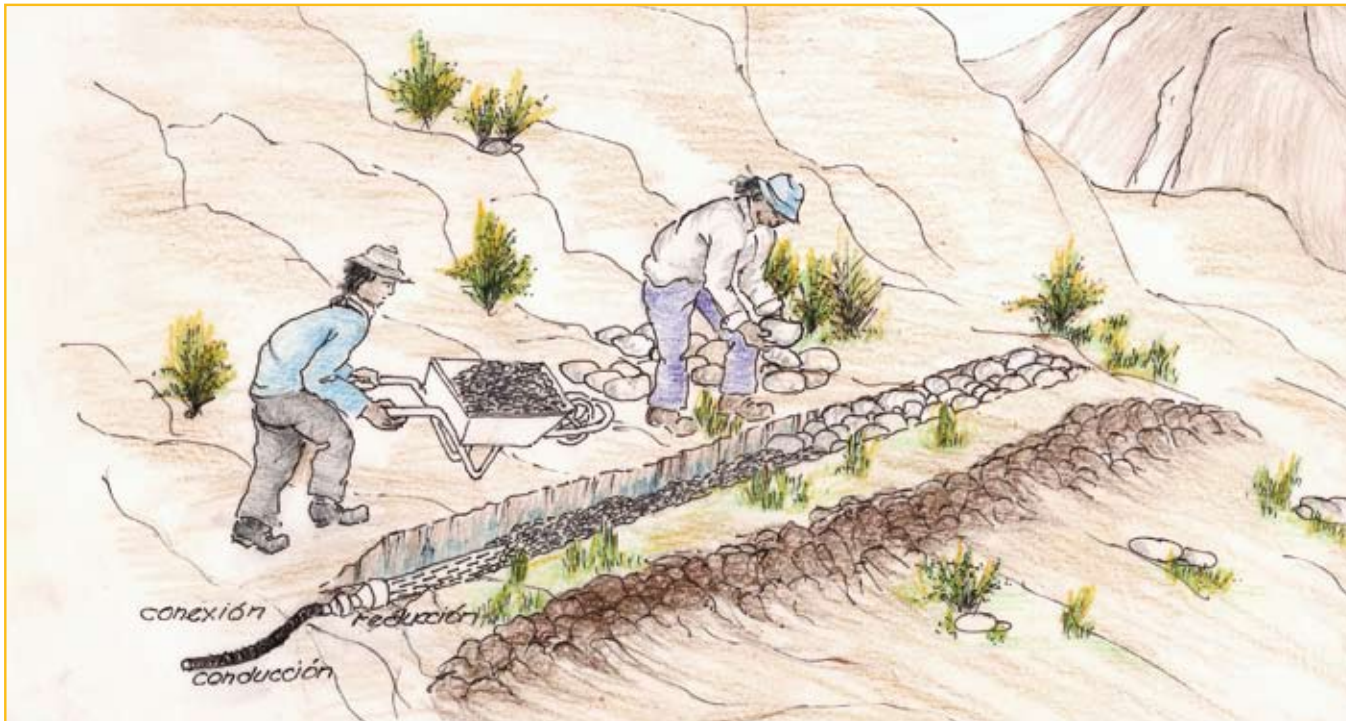
Tapado con ripio y piedra para la terminación de la captación en manantial difuso de ladera.
