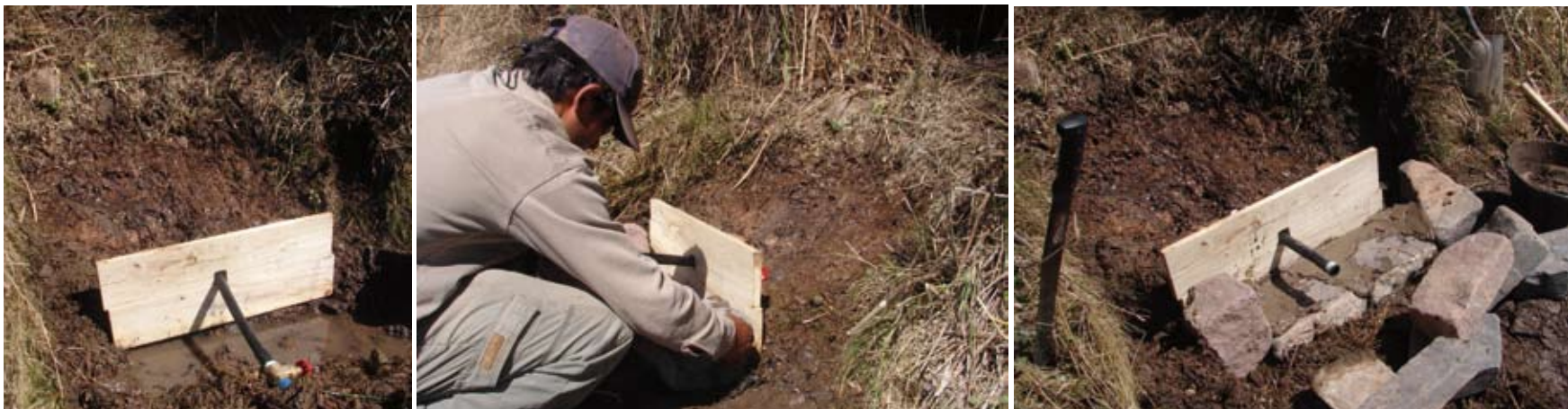
Construcción del muro para la captación del manantial de ladera concentrado. Maimará. Jujuy.
