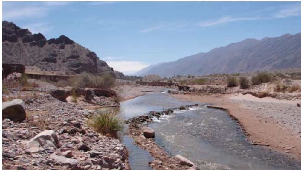
Represamiento realizado con piedra calzada y represamiento con piedra y tierra, se observa la salida lateral de la toma para derivación del agua.
