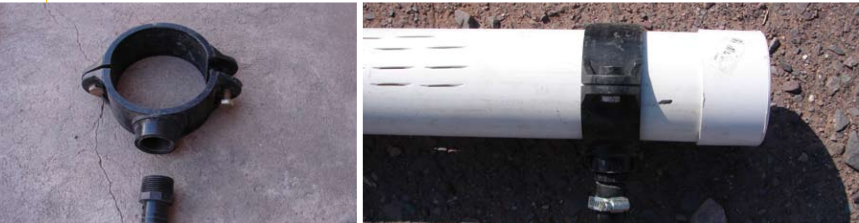
Conexión mediante abrazadera de derivación.
