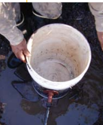
Captación de un manantial realizada con un balde de 20 litros perforado en los laterales, y enterrado. Se observa además la salida a la conducción, también se lo rellena con ripio para mejorar la captación. Maimará.
