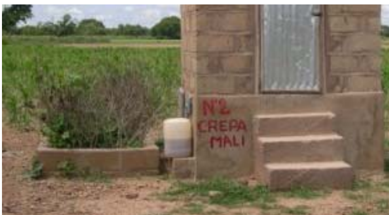
Lit d'évaporation , même principe que le Mulch en pneu mais installation fixe.
