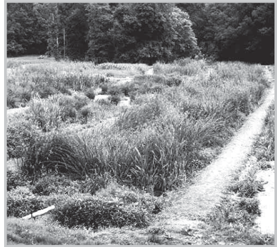
Figura 14. Zona húmeda construida con totora.
