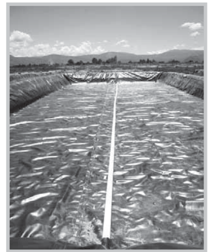
Figura 27. Sistema de drenaje humedal vertical.
