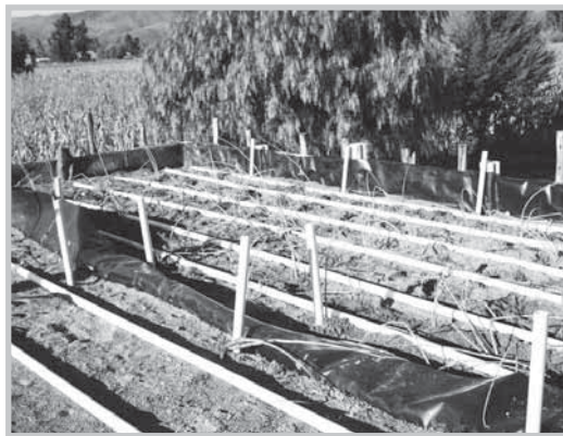
Figura 28. Detalle de sistemas de aplicación de humedal horizontal y dos verticales.
