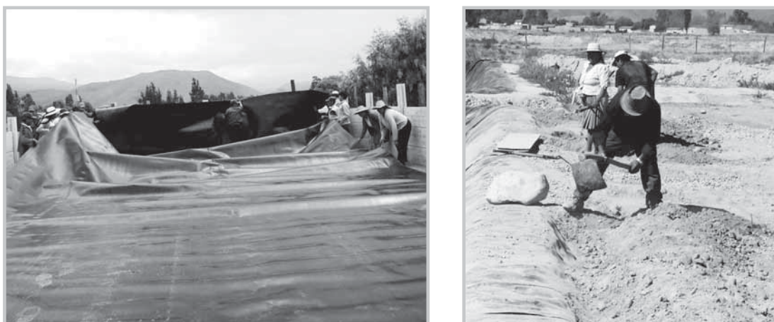
Figura 25. Tendido y anclaje de la geomembrana.
