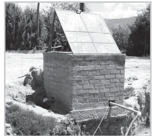
Figura 23. Caseta de bombeo.
