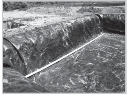
Figura 26. Sistema de drenaje humedal horizontal.
