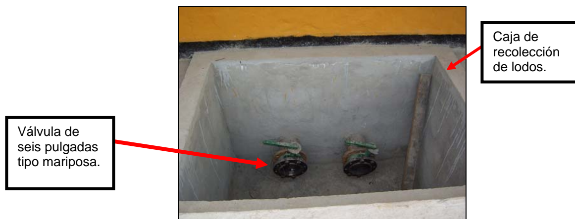
Figura 16. Sistema construido para retirada de lodos, tanques 15Ay 15B.
