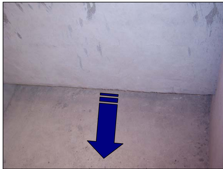
Figura 11. Pantalla interna tanques 15A, 15B y flujo a pistón
