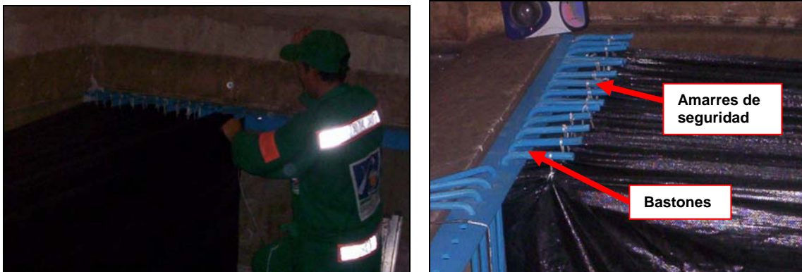
Figura 27. Instalación del geotextil tejido y asegurado contra descolgamiento.
