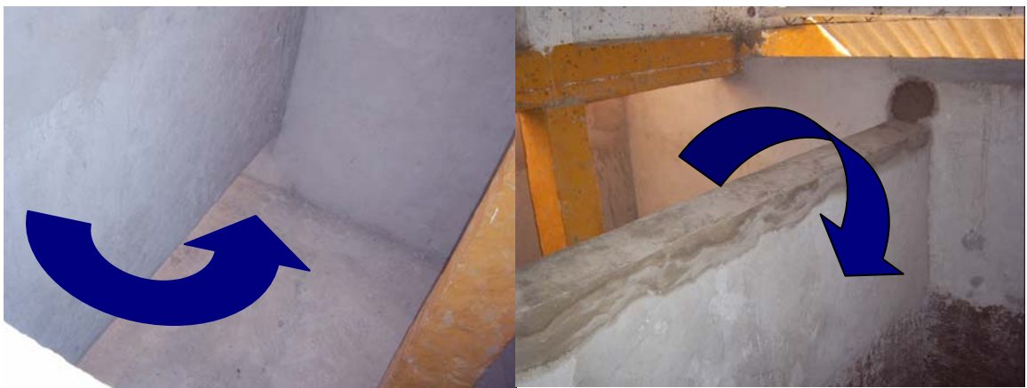
Figura 10. Régimen de flujo a pistón tanques 14 A, 14 B y paso al reactor biológico
