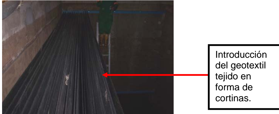
Figura 24. Diseño para la instalación del geotextil tejido
