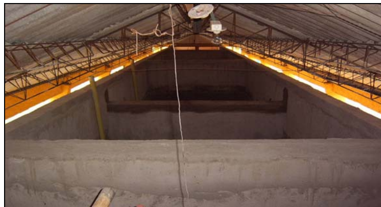
Figura 20. Finalización adecuación de muros, vista interna del reactor.
