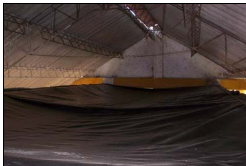
Figura 30. Sellamiento total, tanques 15A y 15B (Reactor biológico)
