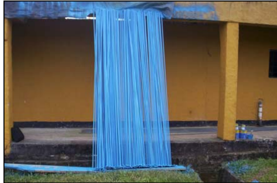
Figura 26. Protección de las varillas con pintura epóxica
