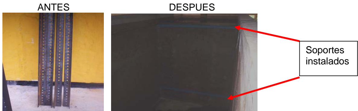
Figura 25. Soportes para varillas antes y después de ser instalados en el tanque 15A
