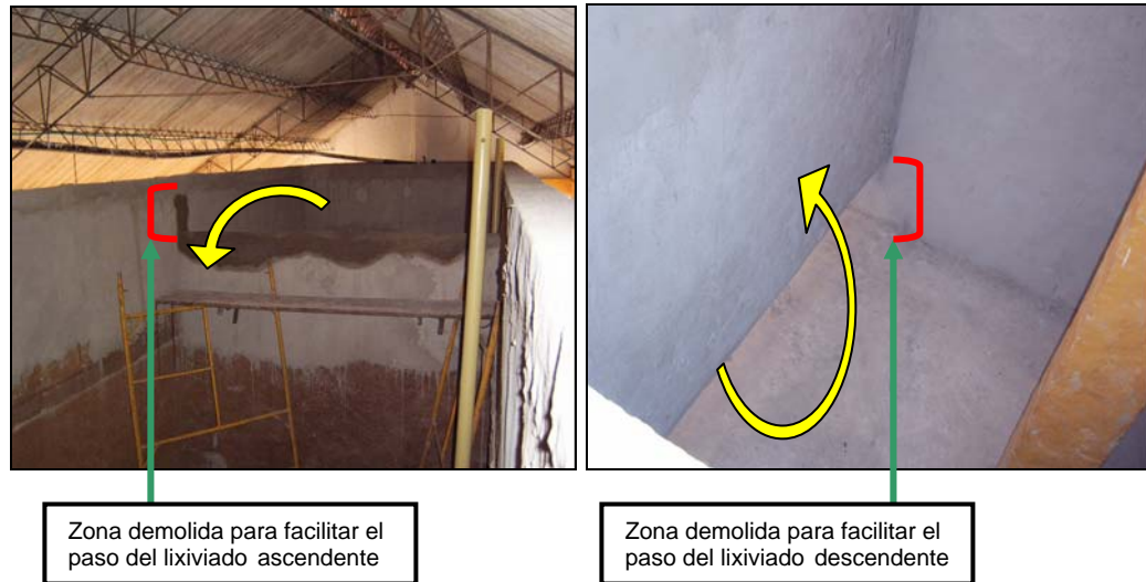
Figura 19. Adecuación de muros en concreto
