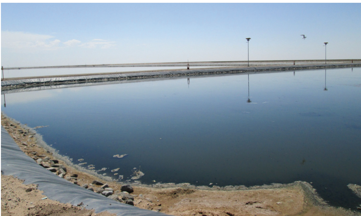
Figura 6 / Laguna de estabilización en la PTAR de San Luis Río Colorado
