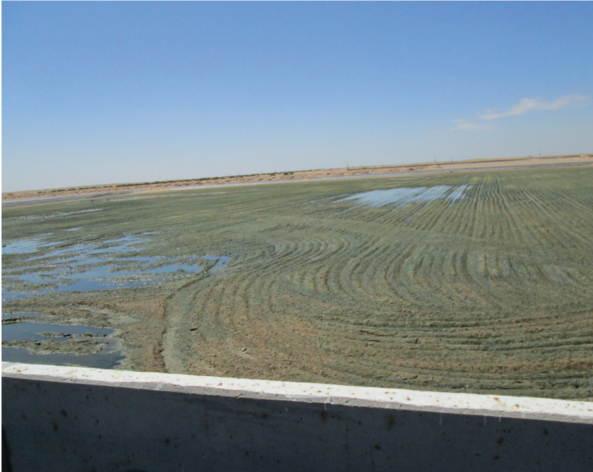
Figura 7 / Laguna de infiltración de la PTAR de San Luis Río Colorado
