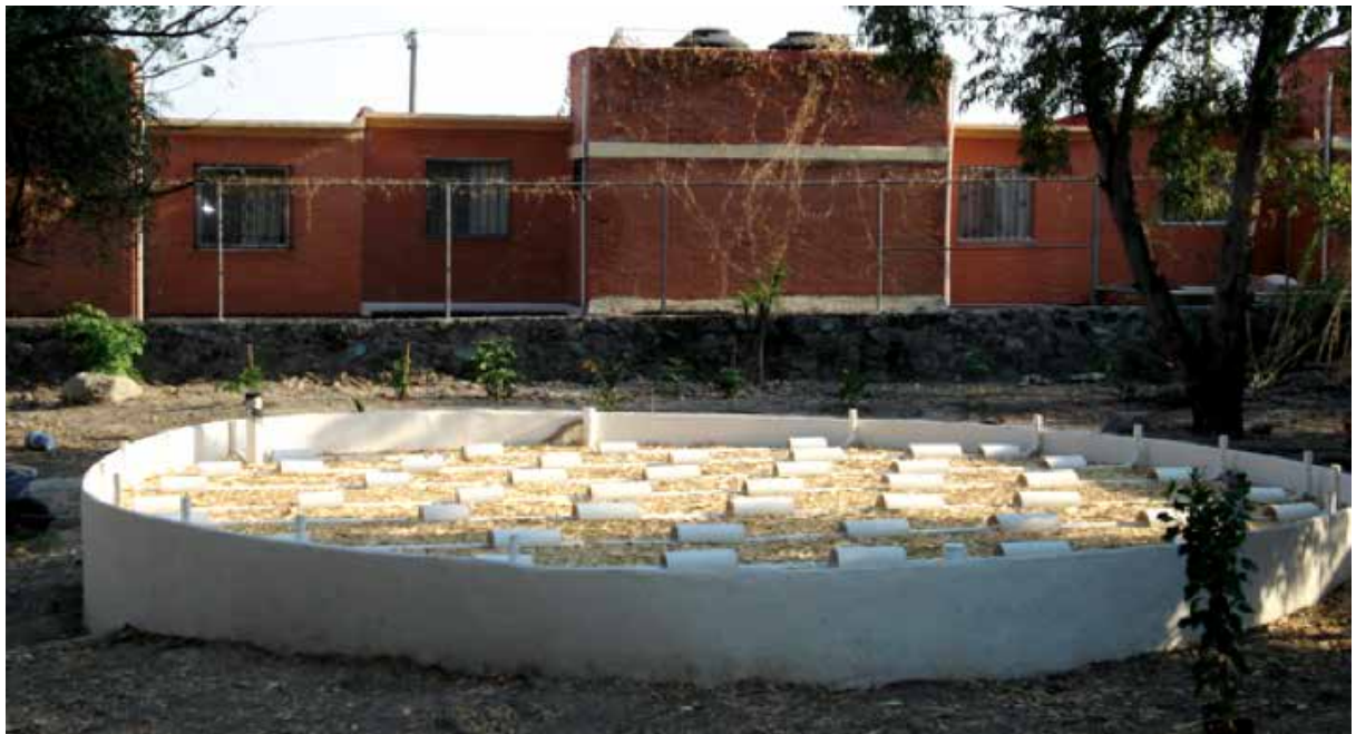
Ilustración 3.13 Biofiltro sobre materiales orgánicos con capacidad para tratar las necesidades de una población de 200 habitantes en Cuernavaca Morelos
