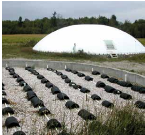
Ilustración 3.10 Biofiltro sobre materiales orgánicos para el tratamiento de agua residual agro-industrial
