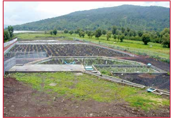
Ilustración 3.3 Humedal artificial de flujo subsuperficial subterráneo
