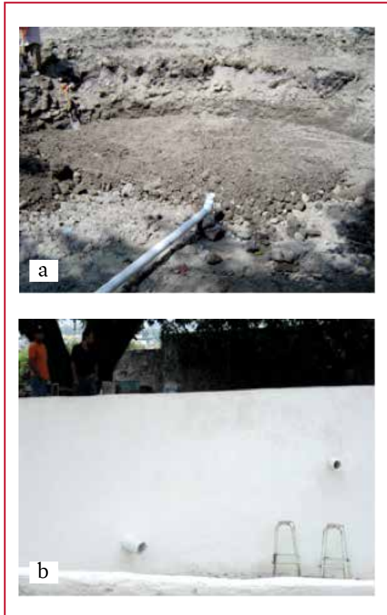
Ilustración 3.9 Se observan a) la instalación de salida de desagüe del biofiltro b) las preparaciones de llegada de agua residual de alimentación (arriba) y preparación de entrada de aire (abajo, izquierda)
