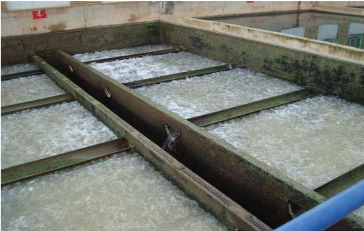
El aire puede aplicarse también en la superficie del lecho expandido por medio de tubos colocados a 0.15 m sobre la máxima elevación del medio filtrante durante el lavado.
