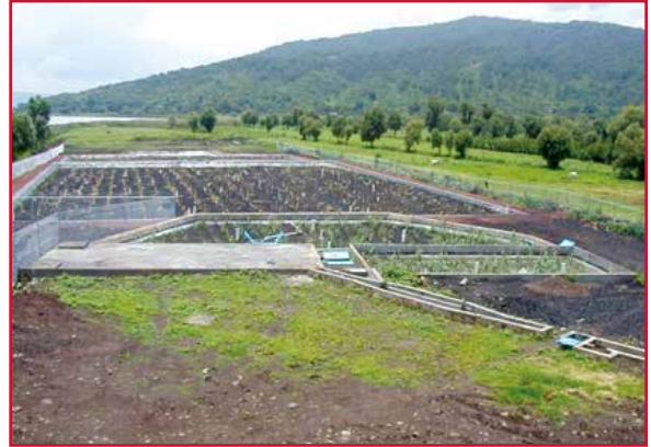
Ilustración 3.3 Humedal artificial de flujo subsuperficial subterráneo
