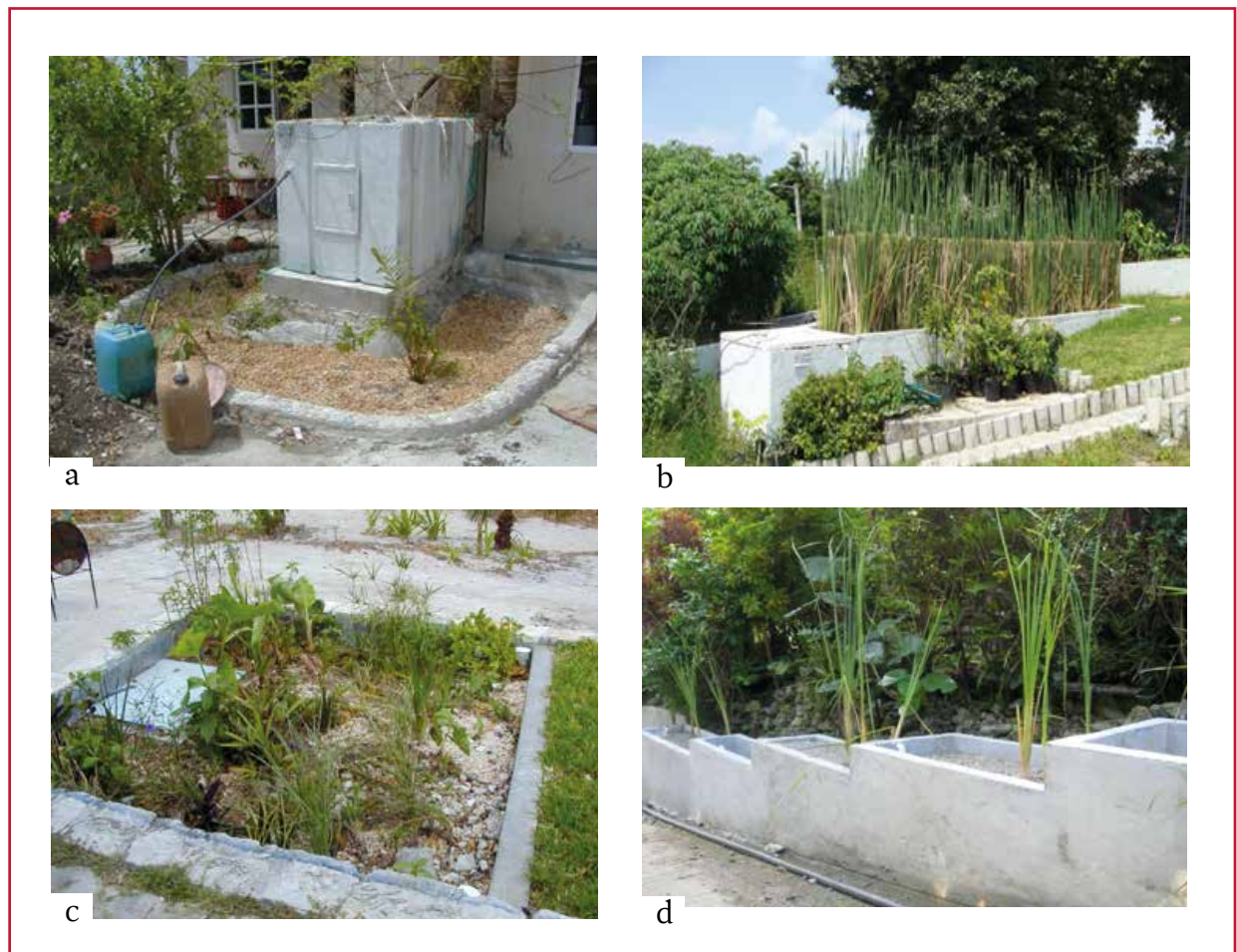
Ilustración 3.2 Humedal artificial tipo familiar
