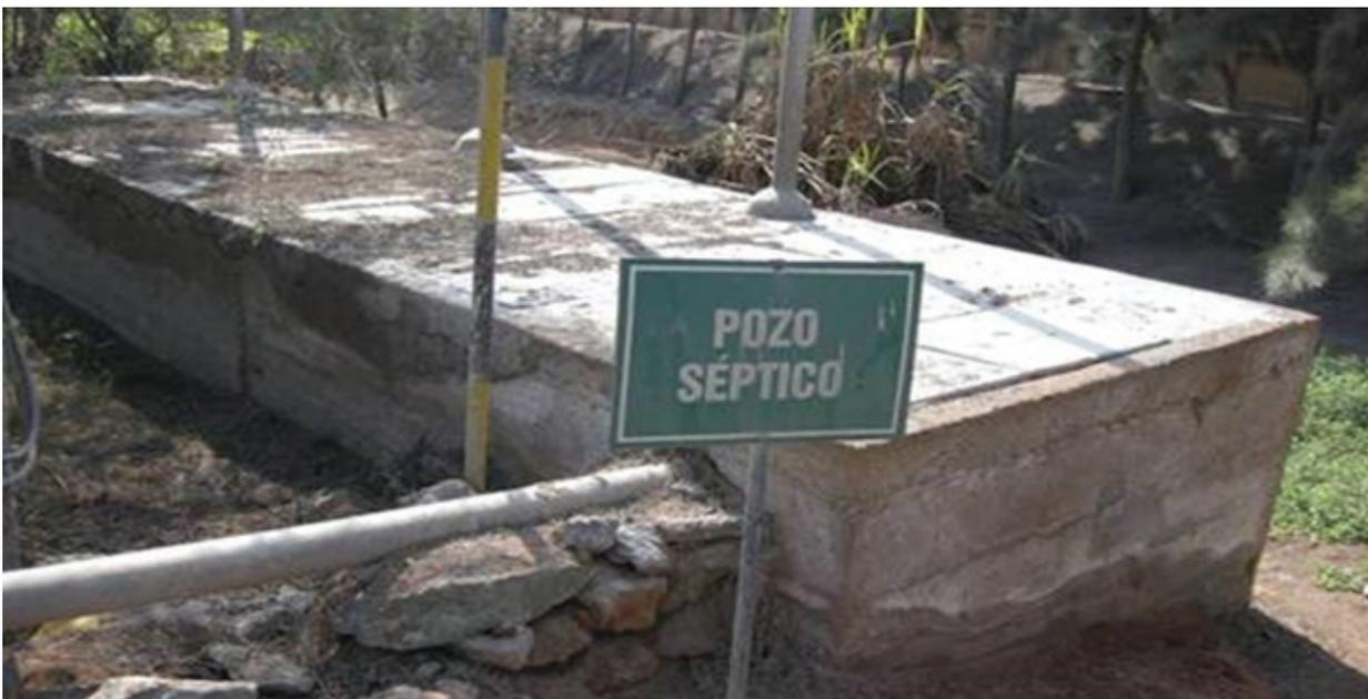
sistente a la corrosión. En algunos diseños, el depósito está equipado con pantallas o deflectores colgantes tanto en la entrada, para conseguir una distribución eficaz del agua y evitar altas velocidades, como en la salida, para evitar que escape la capa de espuma y nata que se forma durante su funcionamiento.
