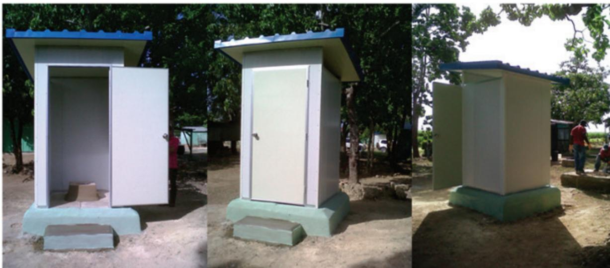
Los líquidos se infiltran en el suelo circundante y el material orgánico se descompone, produciendo gases que escapan a la atmósfera o se dispersan en el suelo. Se generan líquidos que se infiltran en torno al área de influencia de la fosa y se produce un residuo descompuesto (mineralizado) y compactado.
