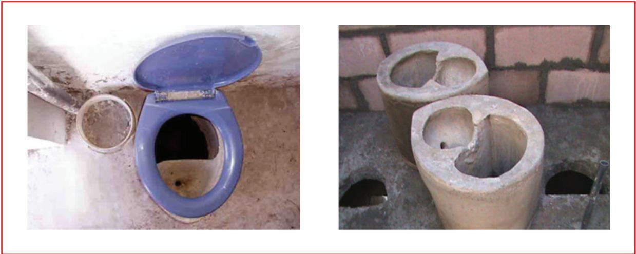
Ilustración 1.11 Esquema de doble cámara en la letrina seca ventilada de dos cámaras
