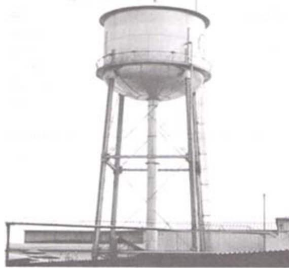
Figura 4.49 Tanque elevado de acero con tapa cónica
