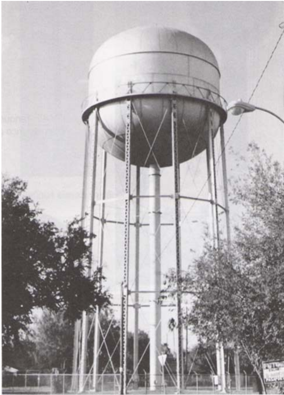
Figura 4.44 Tanques elevados de acero
