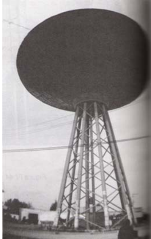
Figura 4.46 Tanque elevado tipo copa de champagne
