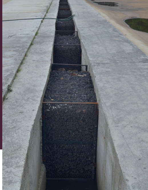
Figura 2.8. Interceptor (derecha: a nivel vivienda cuando se utiliza cisterna, izquierda: a nivel comunitario cuando se usa olla de captación).
