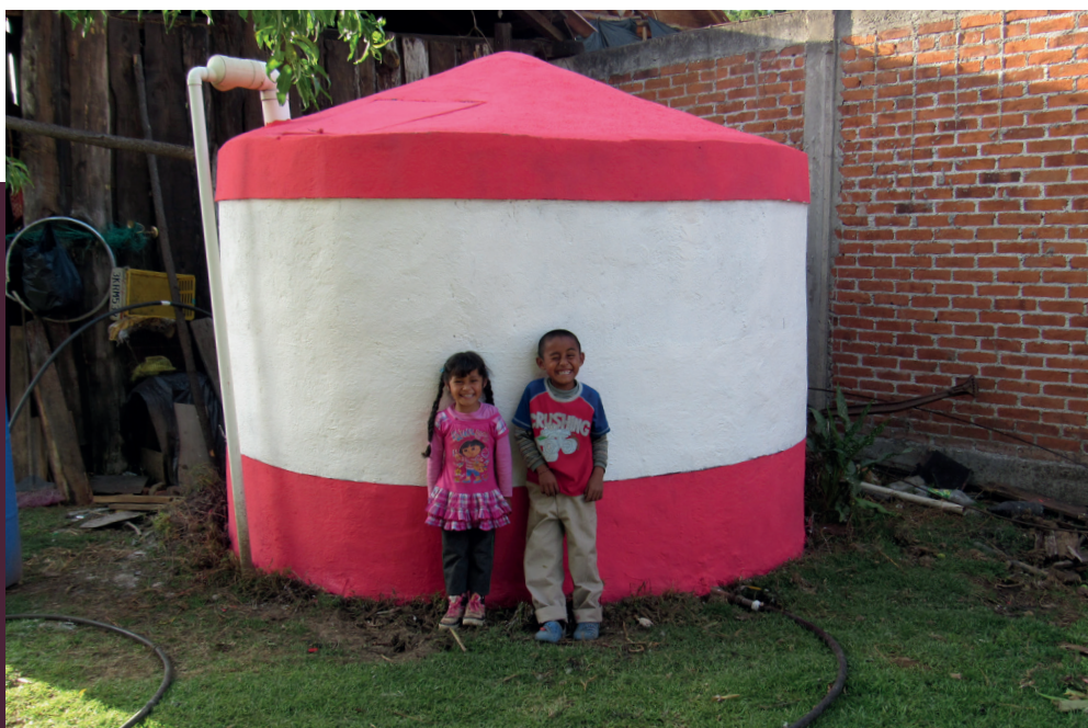
Figura 2.10. Cisterna tipo capuchina.
