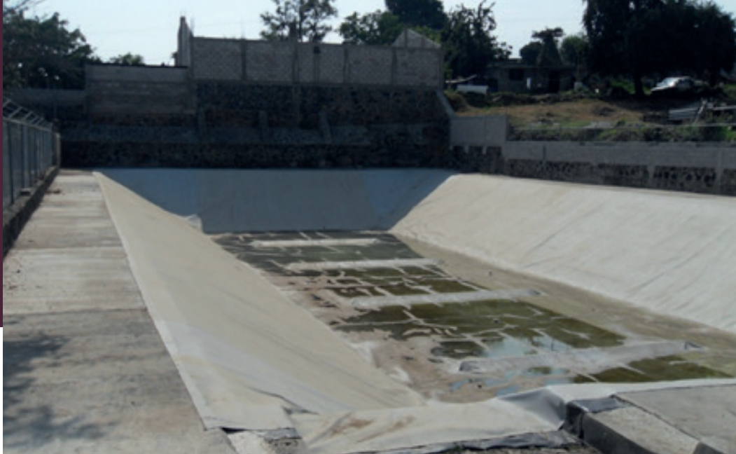
Figura 2.11. Olla de almacenamiento de agua de lluvia para agua de uso doméstico.
