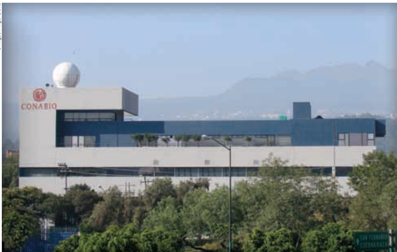
Edificio de la Conabio, ciudad de México.
