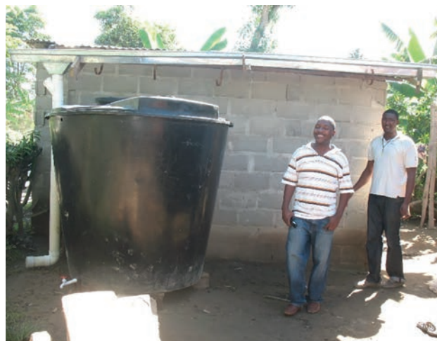
Figura 14. Depósito sobre el terreno natural con sistema de captura de agua inicial sucia con mecanismo de prefiltrado y decantación en Haití (Basán Nickisch et al, 2016b)
