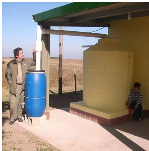
Figura 4. Sistema de trampa inicial de tanque para almacenar el agua sucia para el riego de huerta o forestales
