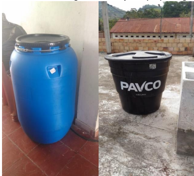
Figura 25 Caneca de 55 galones filtro y Tanque para agua filtrada
